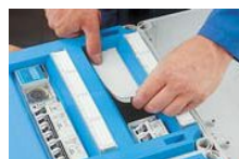
Geräteausschnitte berührungssicher abdecken
