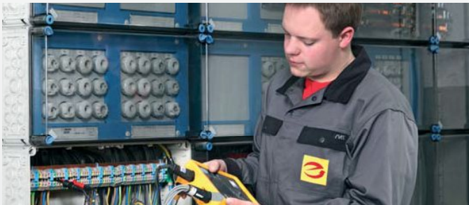
Energie-Schaltgerätekombination (PSC) nach DIN EN 61439-2
