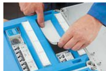
Geräteausschnitte berührungssicher abdecken
